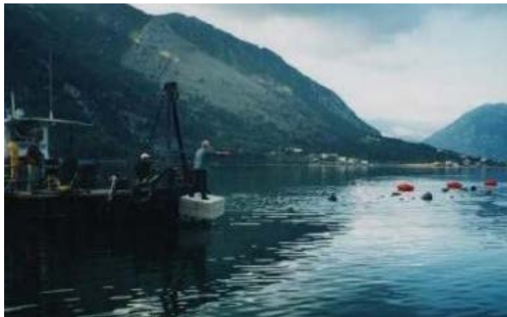
Slika 3.4. Postavljanje sidrišta
